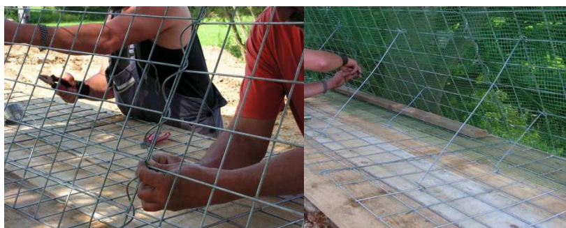
Spojování jednotlivých modulů do sekcí pevným svázáním drátem a instalací spirály. Instalace protierozní sítě a fixačních háků.
